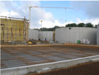
Bau einer Biogasanlage mit Einspeisung. Foto: Ch. Boese
